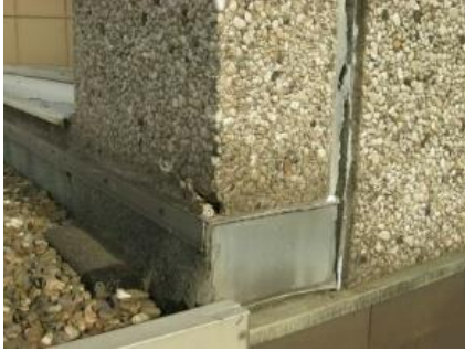
Verschobene Fassadenplatte.
