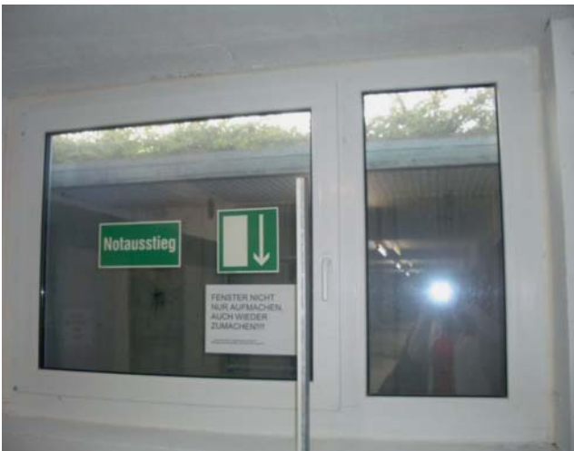
Abb. 5a: Ein Notausstieg, der in einen Lichtschacht führt, oder ... Figure 5a: An emergency hatch leading into a lightwell or ...
