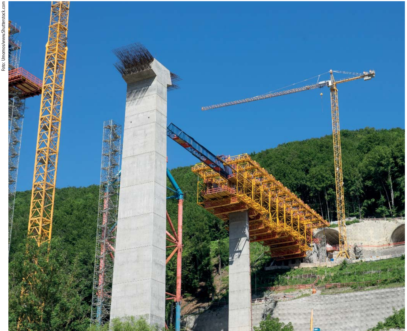
KOMPLEXE BAUWERKE wie dieser kombinierte Tunnel- und Brückenbau für die Eisenbahnstrecke von Stuttgart nach München bedürfen in allen Planungs- und Bauphasen der unabhängigen Kontrolle und Prüfung. COMPLEX STRUCTURES, like this tunnel – and bridge construction for a railway line from Stuttgart to Munich, require independent design review in all phases of planning and construction.
